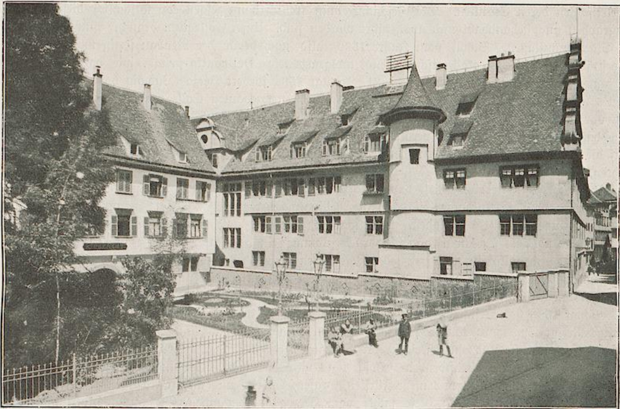
Abb. 3. Westseite des Collegium illustre mit Oberamt (jetzt Direktorswohnung, Bild von 1898).
